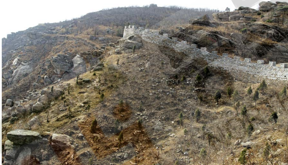
성산산성의 서남벽 복원 구간 성벽의 기초부분은 고구려대의 성벽이고, 성벽의 윗부분(하얗게 보이는 부분)은 중국이 근래 관광지로 개발하면서 복원한 것이다.
