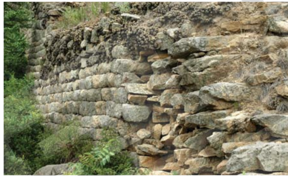
사진 8 결면 성돌 일부가 떨어져 나간 모습 (성산산성)
