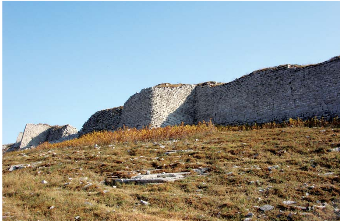
백암성 치 우측의 곡선적인 치는 고구려 때의 것이고, 좌측의 직선적인 치는 명대에 보수한 것이다.
