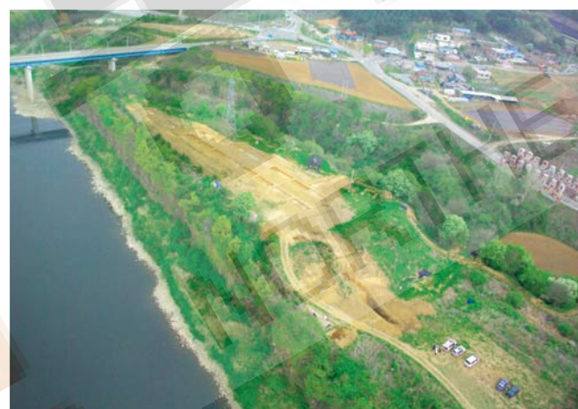
당포성 항공사진(2006년) 남벽과 북벽은 15~20m의 자연 현무암 절벽을 그대로 이용하였고, 동벽만 석축성벽을 쌓았음을 알 수 있다.
